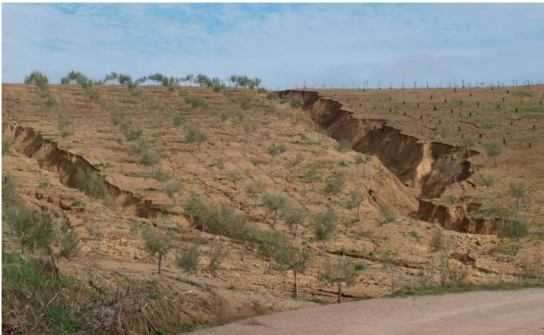
Figura II.3.2. La erosión deja profundas cicatrices en el territorio. Con el suelo se van nutrientes, capacidad de almacenamiento de agua y buena parte de nuestra seguridad alimentaria. Foto de José Alfonso Gómez Calero.
