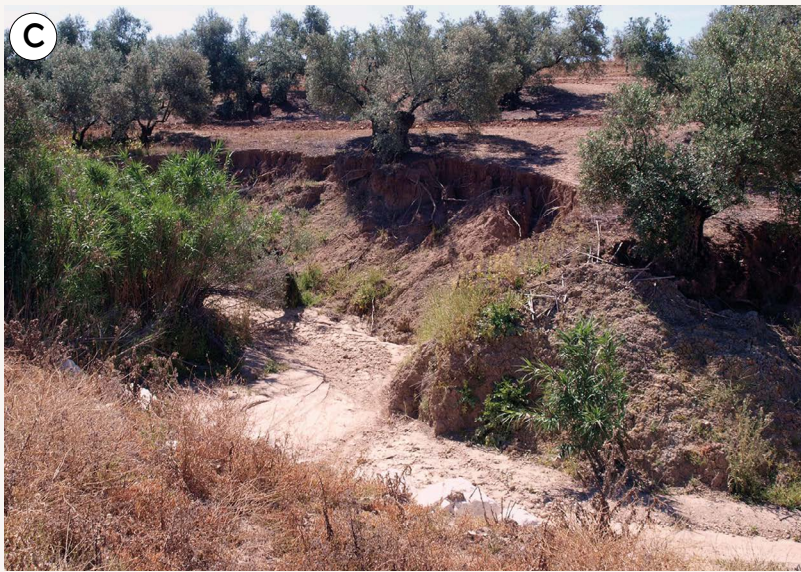
Figura IV.15.7. Imagen de cárcava en olivar (C). Vista de dos olivares en invierno, ambos con cubierta vegetal temporal (A y B). Fotografías de José Alfonso Gómez.
