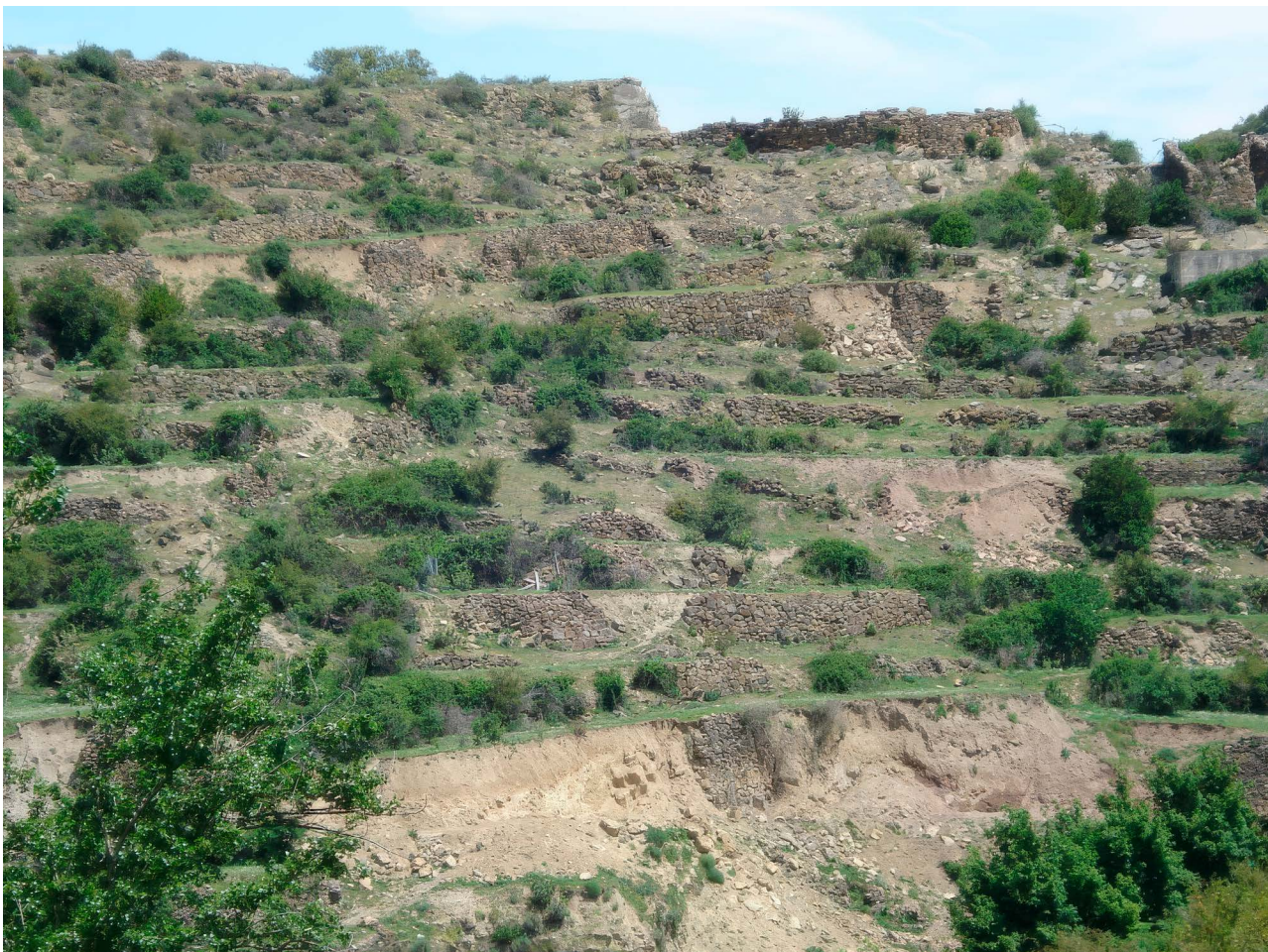
Figura IV.11.2. Caídas en los muros de piedras en bancales abandonados en San Martín del Jubera (La Rioja). Fotografía de Teodoro Lasanta.
